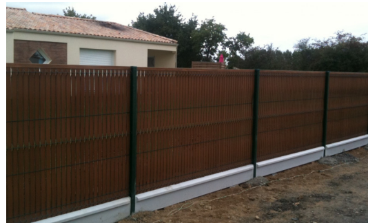
Clôture grillagée doublée de lamelles PVC
