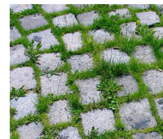
Pavés granit engazonné
