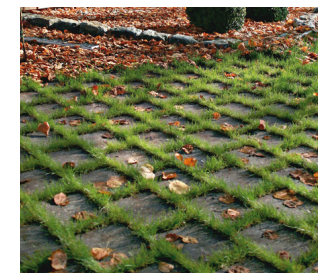
Pavé béton engazonné
